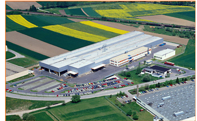
Behr Service GmbH in Schwäbisch Hall
