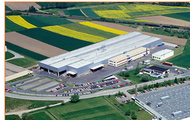
Behr Service GmbH in Schwäbisch Hall
